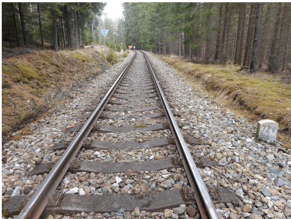
Obr. 5: Nefunkční podélné odvodnění v km 77,600 - pohled po směru staničení
