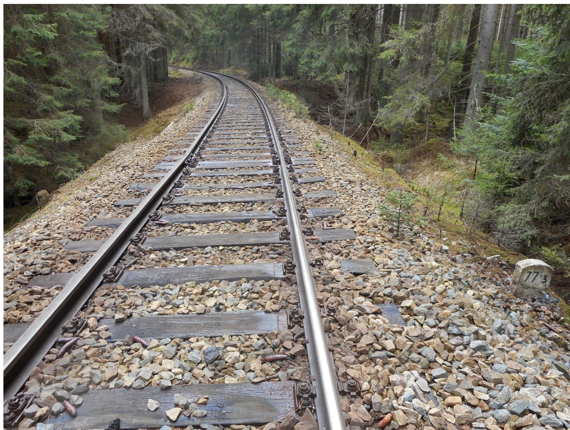
Obr. 4: Sesypávání štěrkového lože na propustku v ev. km 77,284 - pohled proti směru staničení
