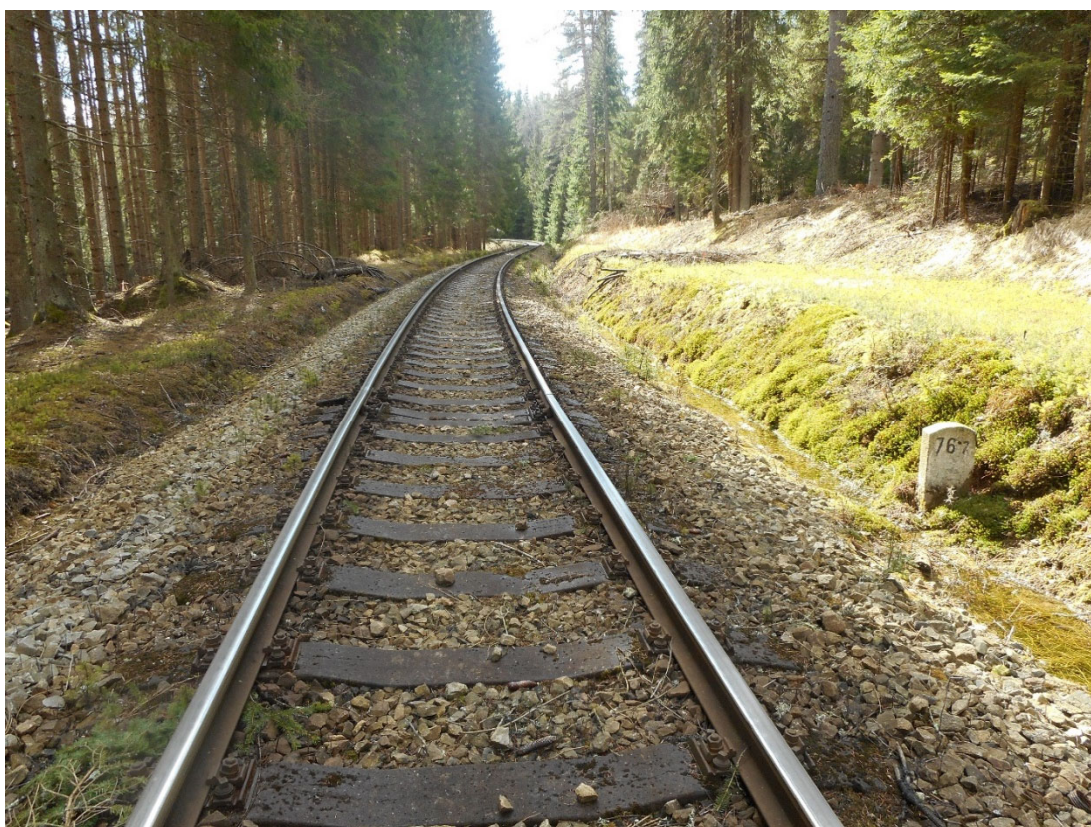
Obr. 2: Nefunkční podélné odvodnění v km 76,700 - pohled proti směru staničení
